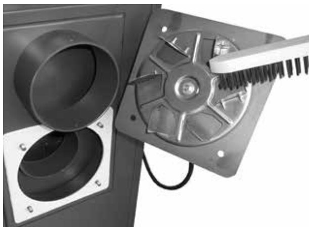
Oczyszczanie koła obiegowego wentylatora spalinowego - kontrola stanu łopatek (u kotły D31P)
