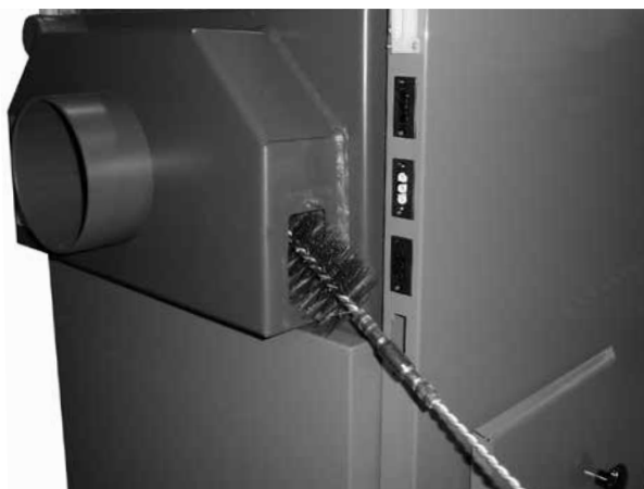
Przykładowe czyszczenie kanału dymowego. Przeprowadzamy po wyczyszczeniu przegrody sitowej w komorze spalania kotła
